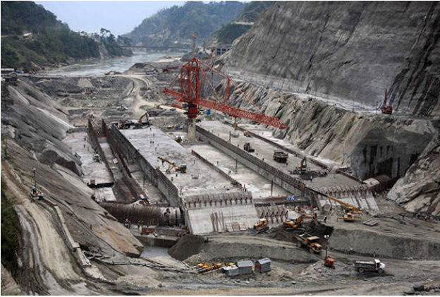
Lower Subansiri Project
